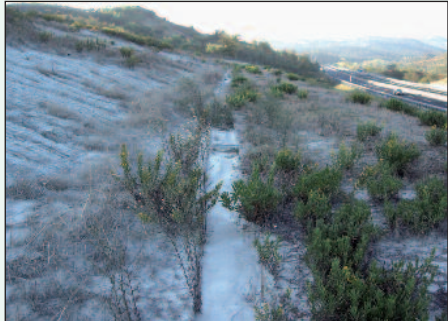
Figure 11A e 11B - Lo stato di conservazione delle canalette. La situazione iniziale (11A) e dopo il trattamento (11B). La manutenzione è stata così azzerata (Autostrada del Sole) (Fonte: Autostrade per l'Italia SpA)
