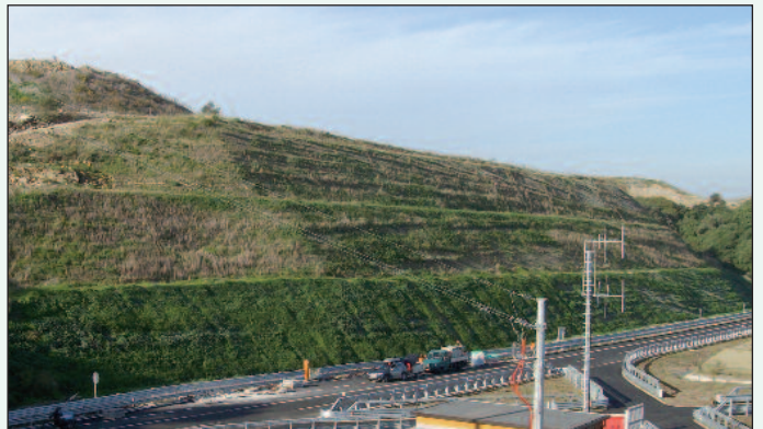
Figure 10A e 10B - La situazione iniziale (10A) e dopo il trattamento (10B). I litotipi presenti sono calcareniti, argilliti e conglomerati (Autostrada CT-SR)
