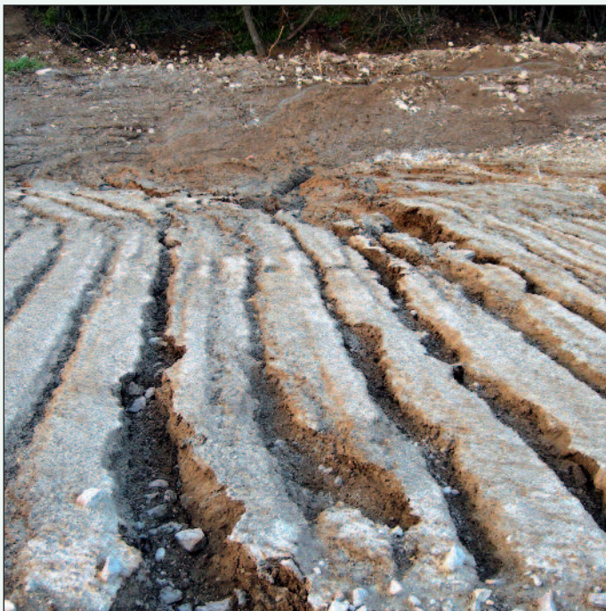
Figura 15 - La forte erosione sul terreno vegetale riportato sui rilevati
