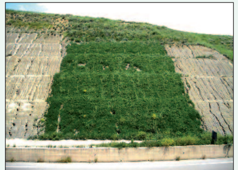
Figure 9A, 9B e 9C - Le piante erbacee a radicazione profonda non necessitano di irrigazione e attecchiscono in condizioni di forte aridità che non consentono la crescita di altre specie vegetali (S.P. ex S.S. 380 "dei Tre Confini", Matera)
