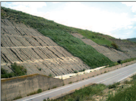
Figure 9A, 9B e 9C - Le piante erbacee a radicazione profonda non necessitano di irrigazione e attecchiscono in condizioni di forte aridità che non consentono la crescita di altre specie vegetali (S.P. ex S.S. 380 "dei Tre Confini", Matera)
