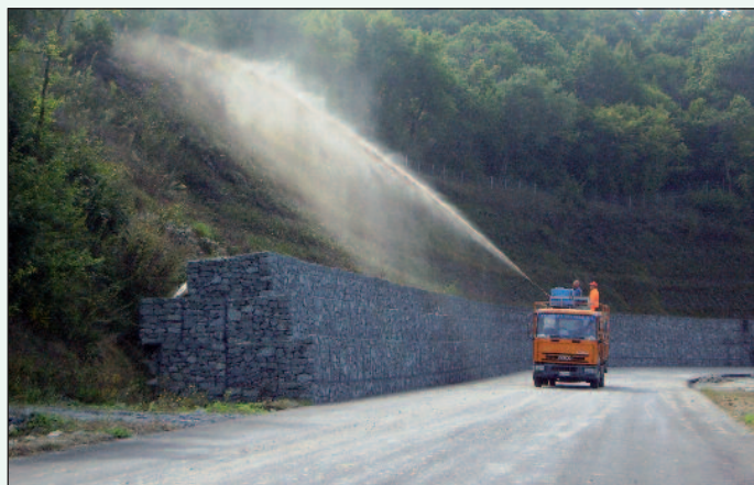
Figura 3 - L'intervento in zone facilmente accessibili
