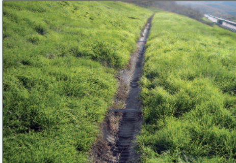
Figure 11A e 11B - Lo stato di conservazione delle canalette. La situazione iniziale (11A) e dopo il trattamento (11B). La manutenzione è stata così azzerata (Autostrada del Sole) (Fonte: Autostrade per l'Italia SpA)
