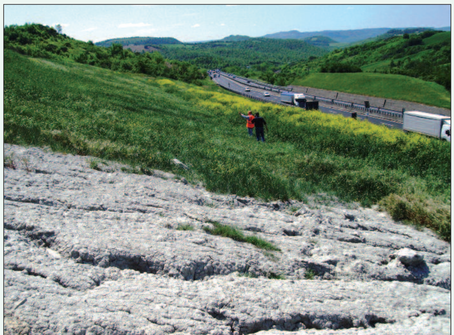
Figura 1 - Un impianto antierosivo realizzato su argille plioceniche sovraconsolidate di origine marina. Si noti il confronto tra l'area non trattata (in primo piano) e l'area trattata (Autostrada del Sole, zona di Fabro - TR)
