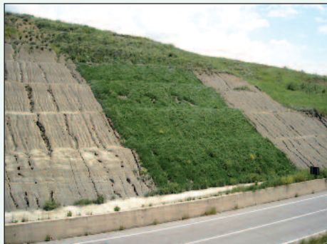
Figure 9A, 9B e 9C - Le piante erbacee a radicazione profonda non necessitano di irrigazione e attecchiscono in condizioni di forte aridità che non consentono la crescita di altre specie vegetali (S.P. ex S.S. 380 "dei Tre Confini", Matera)
