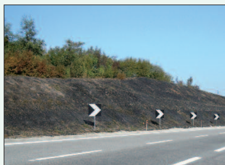
Figure 5A e 5B - La situazione iniziale con le vecchie georeti plastiche rimaste brulle per 15 anni (5A) e rinverdite dopo sei mesi dal trattamento con i Prati Armati® (5B) (Autostrada A6 TO-SV)
